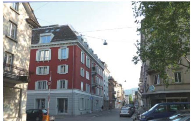
Ancien immeuble entièrement rénové de la Wogeno, Zurich
